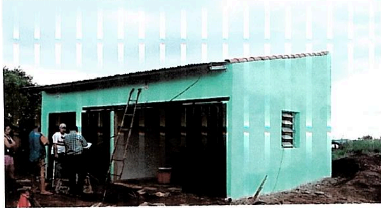
Centro de acopio construido
